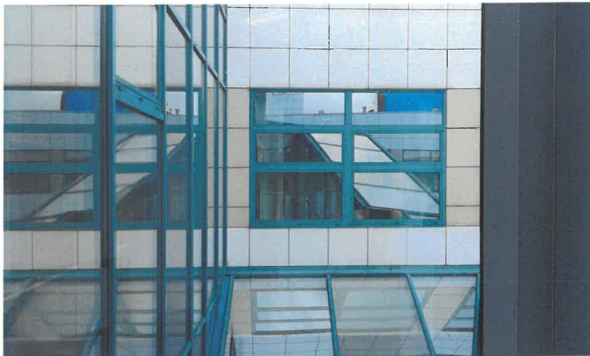
styk elewacji na granicy stref pożarowych – bez zachowanej odległości pomiędzy otworami okiennymi
