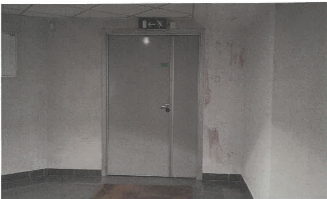
przejście do garażu A-1 - drzwi zwykłe, bez odporności pożarowej
