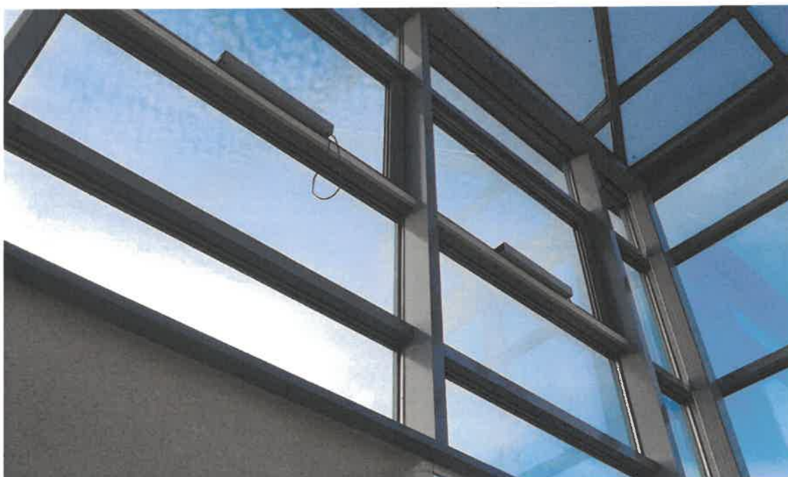
klatka schodowa - system oddymiania
