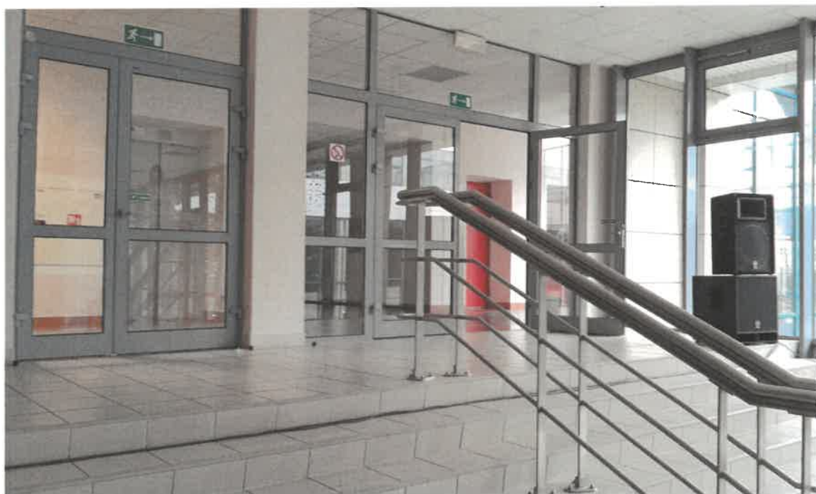
hall sal audytoryjnych – ściana wewnętrzna bez wymaganej odporności pożarowej
