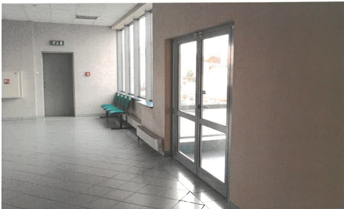
drzwi z klatki schodowej - bez wymaganej odporności pożarowej, szerokość w świetle 90cm
